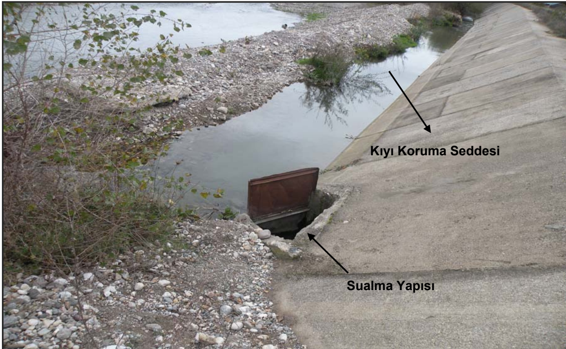
Şekil 33. Mansaptaki Araç-Balçıkhisar Köyü ve Bostan Mahallesi Sulama Tesisi Su Alma Yapısı
