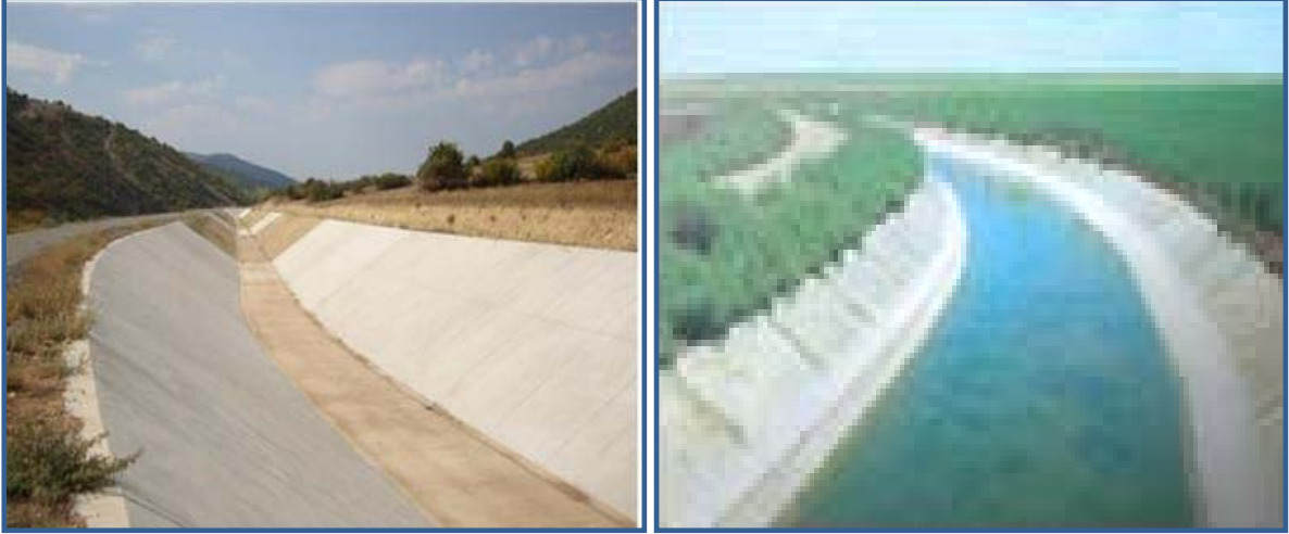
Şekil 48. Trapez Kesitli Kanal
