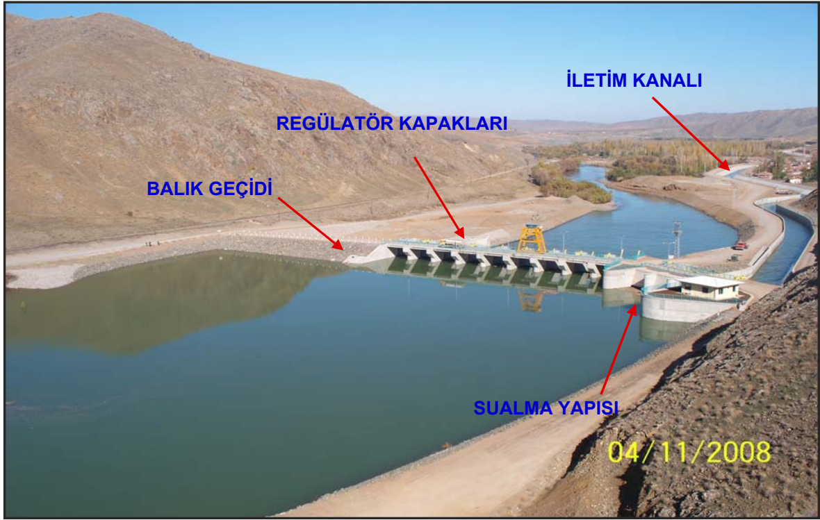
Şekil 47. Kapaklı Regülatör (Hamzalı Regülatörü)
