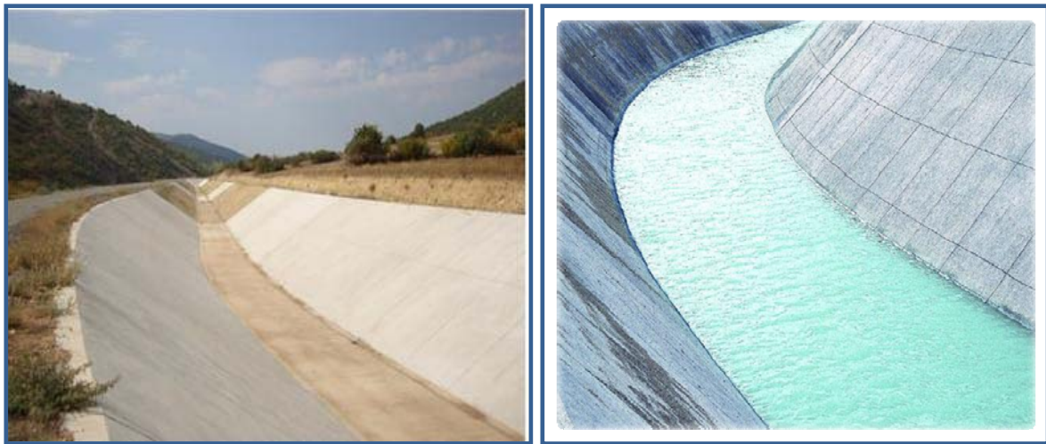
Şekil 42. Trapez Kesitli Kanal
