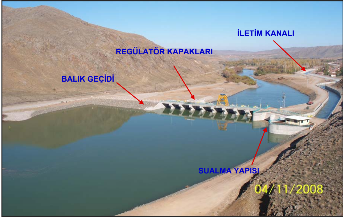
Şekil 41. Kapaklı Regülatör (Hamzalı Regülatörü)
