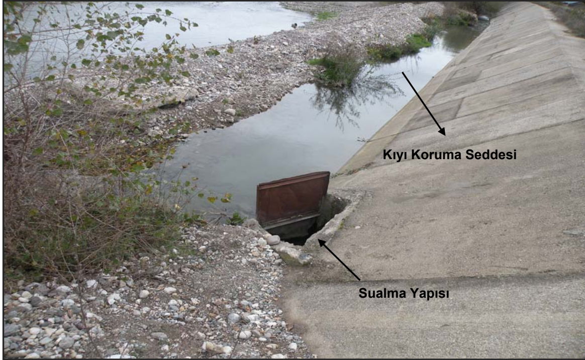
Şekil 26. Mansaptaki Araç-Balçıkhisar Köyü ve Bostan Mahallesi Sulama Tesisi Su Alma Yapısı
