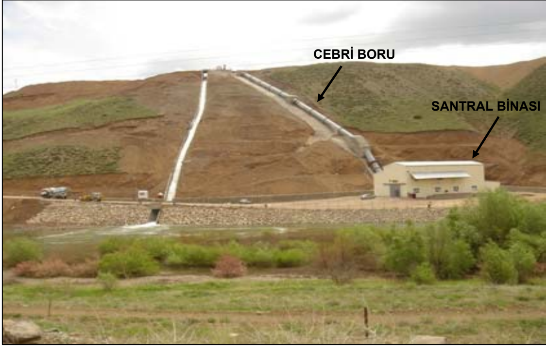
Şekil 45. Hidroelektrik Santral Binası
